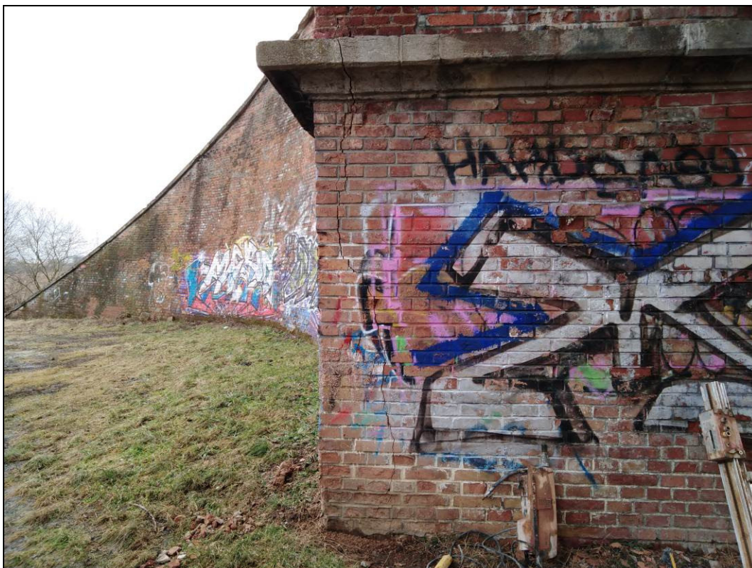
Obr. č. 12 - pohled na opěru Brno – trhlina ve spodní stavbě
