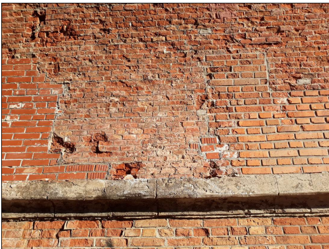
Obr. č. 13 – opad cihelného zdiva nosné konstrukce
